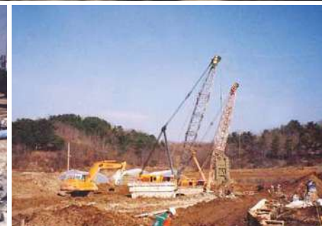
차수벽 CD Wall 공사
