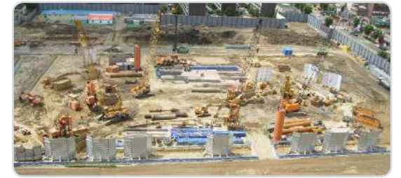
인천 풍림엑슬루타워 RCD 시공전경
