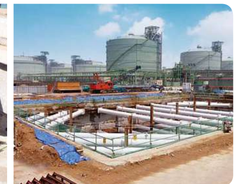
평택 LNG 탱크터미널 기초보강공사 · 굴착깊이 : 15.5~20.9m · PPS 설치 단수 & 길이 : 3~4 layer / 840m · PPS 직경 : ø 800mm
