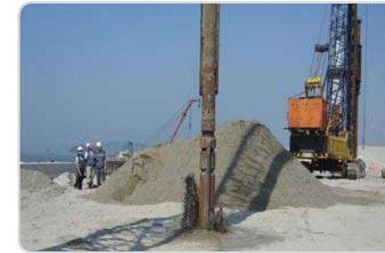
Probe Probe 지반내 관입 단계
