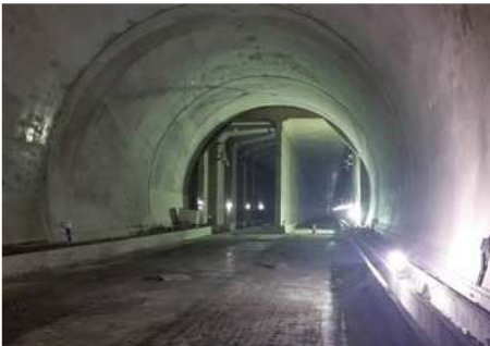
▲ 수서~평택 수도권고속철도 (제1-2공구) 터널공사
