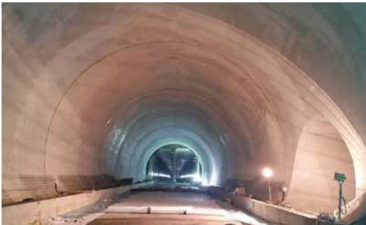
▲ 수서~평택 수도권고속철도 (제1-2공구) 터널공사
