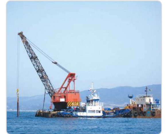
알제리 젠젠항 방파제 증축공사 중 기초지반 개량공사
