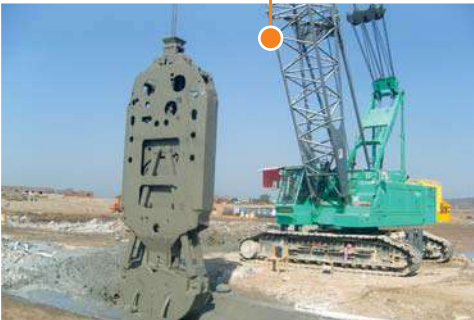
▲ 파키스탄, 뉴봉 수력발전소 차수벽 공사
