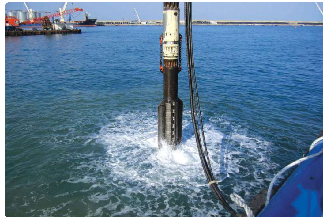
군산 조전소 도크 하부기초 스톤컬럼 공사
