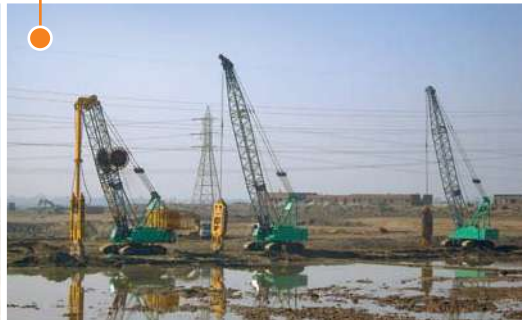
▲ 파키스탄, 뉴봉 수력발전소 차수벽 공사
