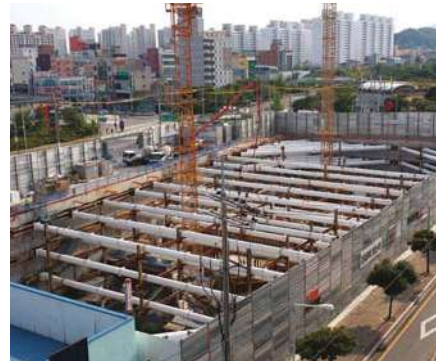
광양 E-편한세상 · 굴착깊이 : 15.5~20.9m · PPS 설치 단수 & 길이 : 3 layer / 2,320m · PPS 직경 : ø 800mm
