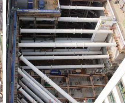
상암 두산 위브 센티움 신축공사 · 굴착깊이 : 19.0~23.0m · PPS 설치 단수 & 길이 : 3~4 layer / 840m · PPS 직경 : ø 800~1,000mm
