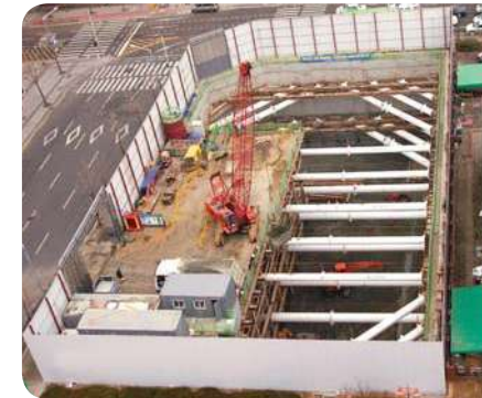
국제 템플스테이 신축공사 · 굴착깊이 : 14~20m · PPS 설치 단수 & 길이 : 2 layer / 630m · PPS 직경 : ø 800mm
