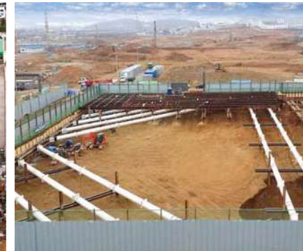
위례신도시 아이에스 센트럴 타워 신축공사 · 굴착깊이 : 14.0~18.5m · PPS 설치 단수 & 길이 : 3~4 layer / 1,740m · PPS 직경 : ø 800mm
