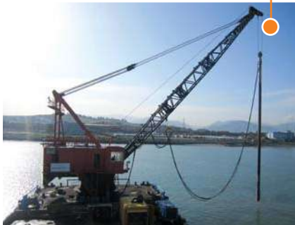
▲ 알제리, 젠젠항 해상 바이브로 컴팩션공사
