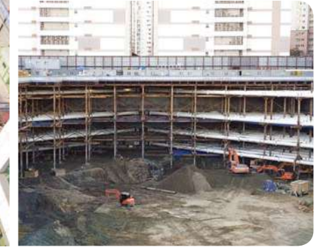
부산 용호만 복합시설 신축공사 · 굴착깊이 : 21.5m · PPS 설치 단수 & 길이 : 4 layer / 1,850m · PPS 직경 : ø 800mm
