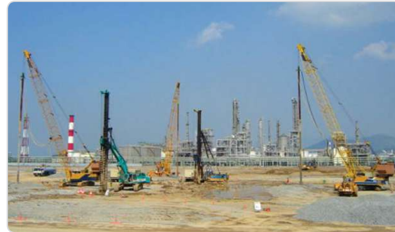
여수GS칼텍스 VDU TANK VDU 스톤컬럼 현장
