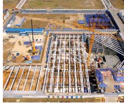
마곡 코오롱 미래기술원 신축공사 · 굴착깊이 : 13.9~17.9m · PPS 설치 단수 & 길이 : 2 layer / 3,260m · PPS 직경 : ø 800mm
