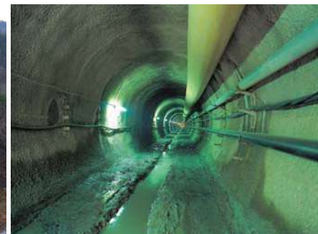
수도권 상수도 복선화사업 터널공사
