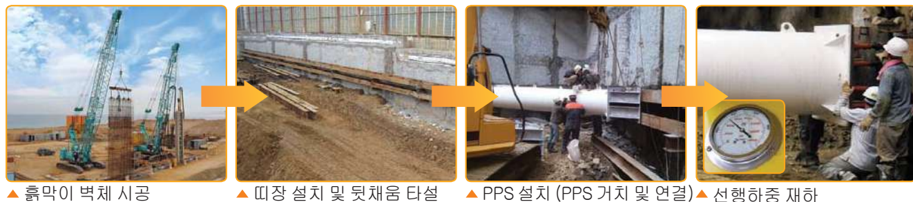
▲ 흙막이 벽체 시공
