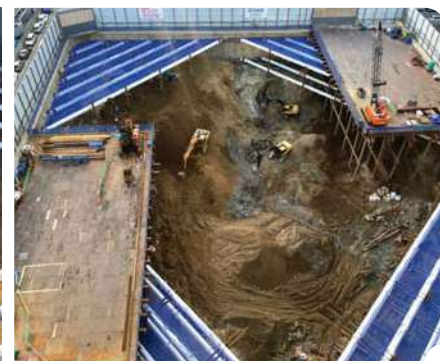
안양 평촌 아이에스비즈타워 신축공사 · 굴착깊이 : 16.3~19.3m · PPS 설치 단수 & 길이 : 3 layer / 2,707m · PPS 직경 : ø 800mm
