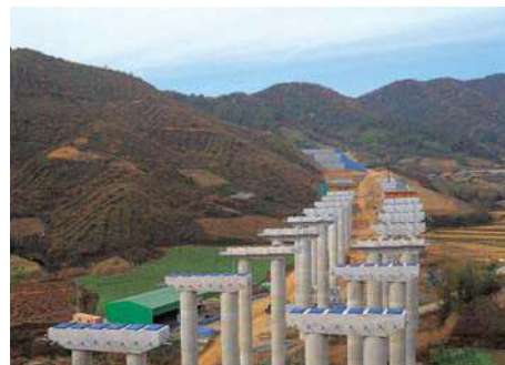
중부내륙고속도로, 매현교 설치공사
