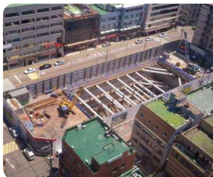
잠실 1st PARK 신축공사 · 굴착깊이 : 18.8~23.7m · PPS 설치 단수 & 길이 : 3 layer / 1,000m · PPS 직경 : ø 800mm
