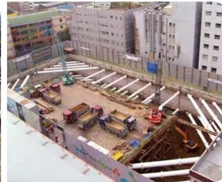
성수동 우리은행 콜센터 · 굴착깊이 : 17.5~21.0m · PPS 설치 단수 & 길이 : 2~3 layer / 1,400m · PPS 직경 : ø 800mm
