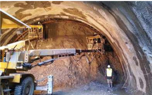
▲ 수서~평택 수도권고속철도 (제1-2공구) 터널공사
