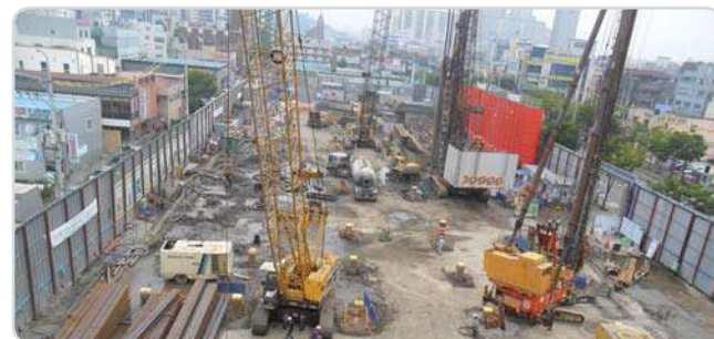
울산 업스퀘어 바렛파일 시공전경
