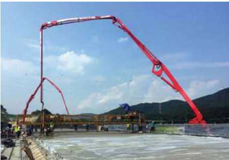
▲ 구리~포천 고속도로 (제3공구) 터널공사
