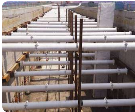
인천국제공항 제2여객터미널 연결철도 · 굴착깊이 : 21.0~25.0m · PPS 설치 단수 & 길이 : 2~3 layer / 6,000m · PPS 직경 : ø 800mm
