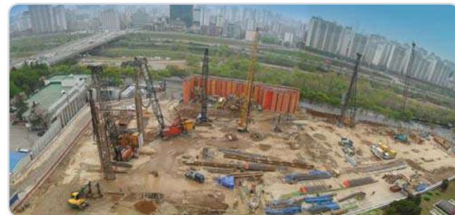
여의도 국회의원회관 바렛파일 시공전경
