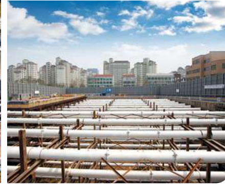
우면 삼성전자 R&D 센터 신축공사 · 굴착깊이 : 15.5~20.9m · PPS 설치 단수 & 길이 : 3~4 layer / 5,656m · PPS 직경 : ø 800mm
