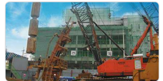
망우동 한일주거복합빌딩 RCD 시공
