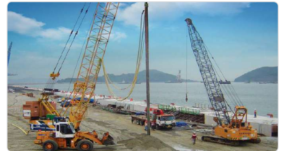
부산신항 1-2단계 안벽배면 진동다짐 현장 시공전경
