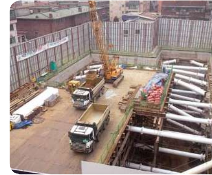
석촌동 불광사 중창불사 신축공사 · 굴착깊이 : 20.5~22.9m · PPS 설치 단수 & 길이 : 3 layer / 711m · PPS 직경 : ø 800mm
