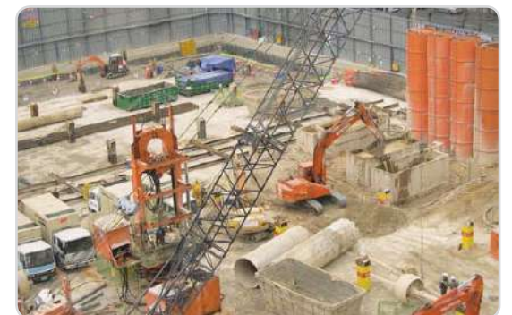
굿모닝시티 RCD 시공전경
