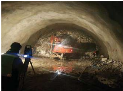
▲ 구리~포천 고속도로 (제3공구) 터널공사
