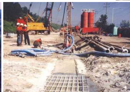
속초 취수장 지하댐 설치공사
