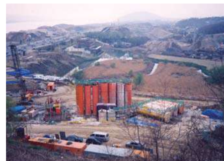
난지도 쓰레기 처리장 침출수 차수벽공사
