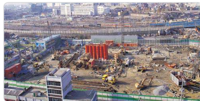
한강로 벽산주상복합 바렛파일 시공전경
